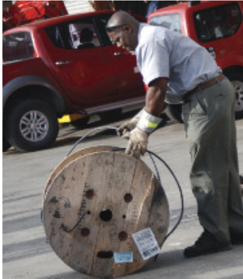
Rolling out cable
